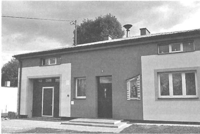
Budynek OSP w Zarębkach
