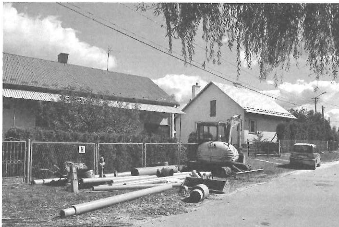
Budowa kanalizacji w Kolbuszowej Górnej
