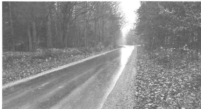
Przebudowana droga gminna Poręby Kupieńskie- Budy Głogowskie.
