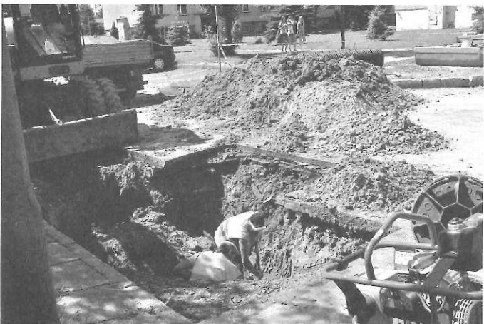
Budowa kanalizacji na ul. Partyzantów.
