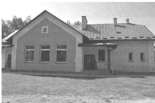
Dawna szkoła w Nowej Wsi po termomodernizacji
