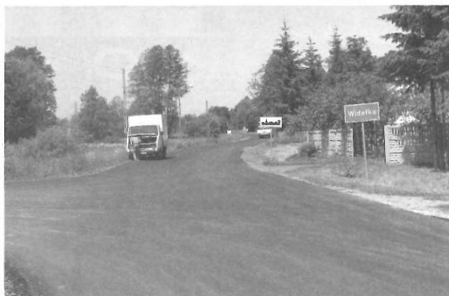
Remont drogi powiatowej w Widelce. Fot. B. Żarkowska
