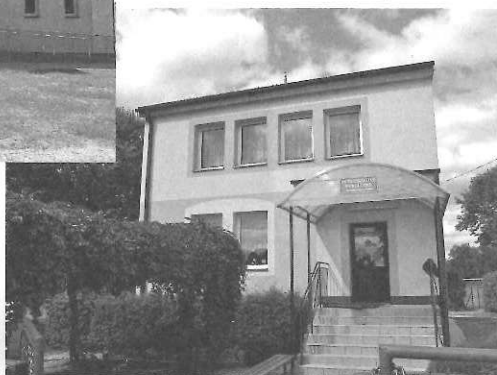
Przedszkole w Kolbuszowej Dolnej po termomodernizacji.
