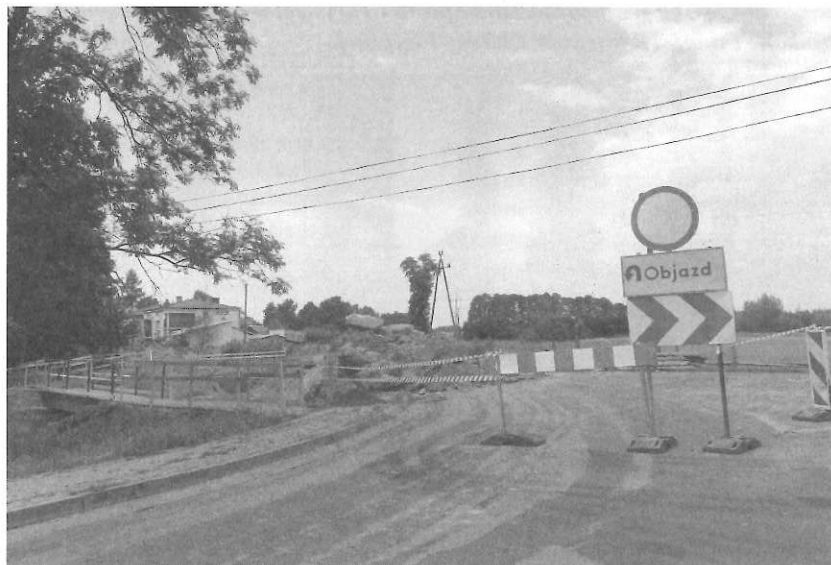
bż Przebudowa mostu na rzece Olszynka trwa. Fot. B. Żarkowska
