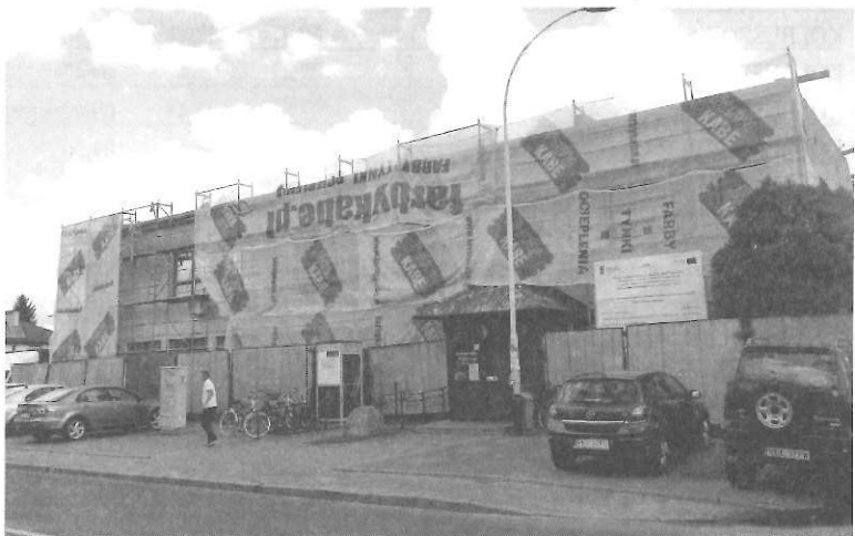
Budynek Powiatowego Urzędu Pracy w tym roku przejdzie generalny remont. Fot. B. Żarkowska
