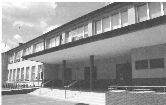
W III kadencji docieplone zostały ściany budynku w budynku Zespołu Szkół Technicznych. Wymieniony został dach na szkole oraz sali gimnastycznej. W budynku została również zmodernizowana instalacja elektryczna oraz centralnego ogrzewania.
