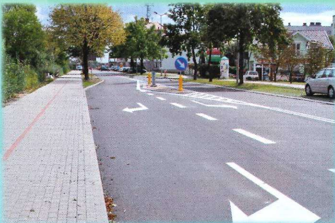
Przebudowa ul. Ruczki.
