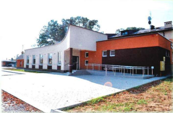
Budynek usługowo - handlowy przy ul. Wolskiej.
