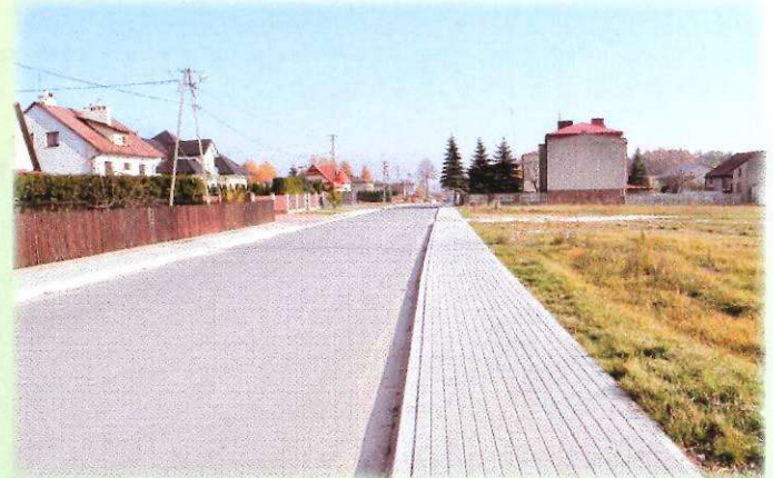
Przebudowa kanalizacji na ul. Krakowskiej
