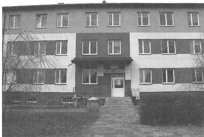
Przychodnia Rejonowa nr 1 w Kolbuszowej po generalnym remoncie.
