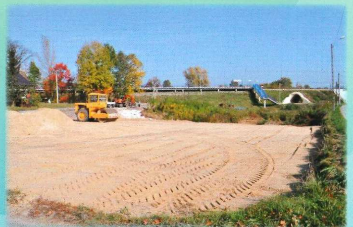
Budowa miejsc parkingowych w Widelce.
