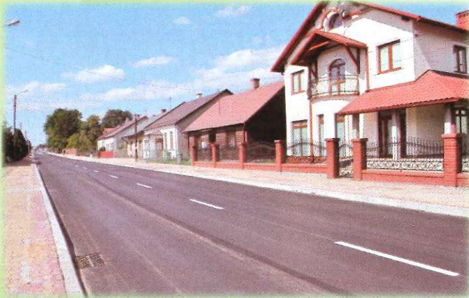
Przebudowa kanalizacji na ul. Obrońców Pokoju
