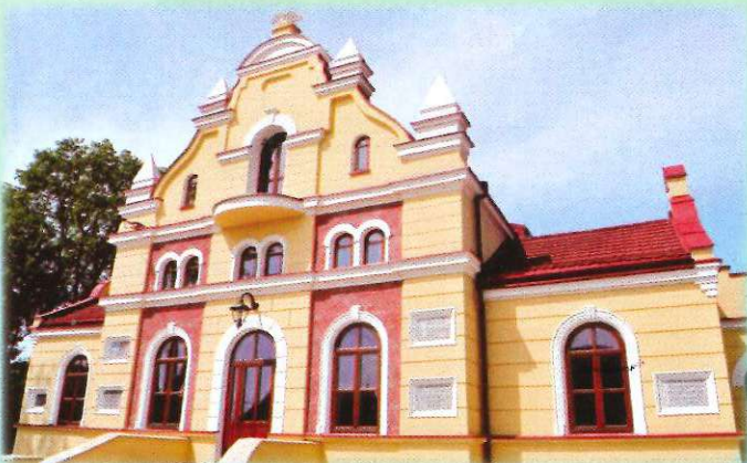
Miejski Dom Kultury po termomodernizacji.
