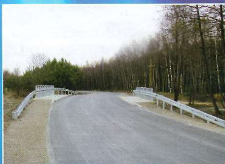
Przebudowany most w Zarębkach.
