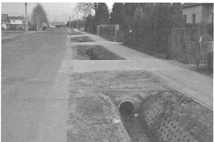
Budowa chodnika w Nowej Wsi
