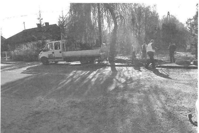
Przebudowa kanalizacji w rejonie ul. Narutowicza
