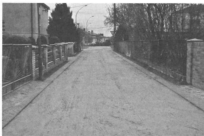
Ulica Reymonta po przebudowie
