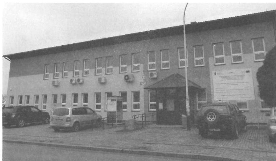
Odremontowany budynek Powiatowego Urzędu Pracy w Kolbuszowej. Fot. B. Żarkowska
