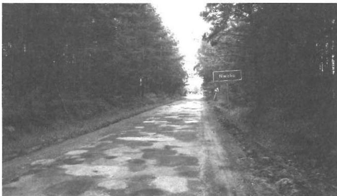
W trakcie jest przebudowa odcinka drogi powiatowej nr 1 229 R Niwiska – Huta Przedborska. Fot. A. Stec
