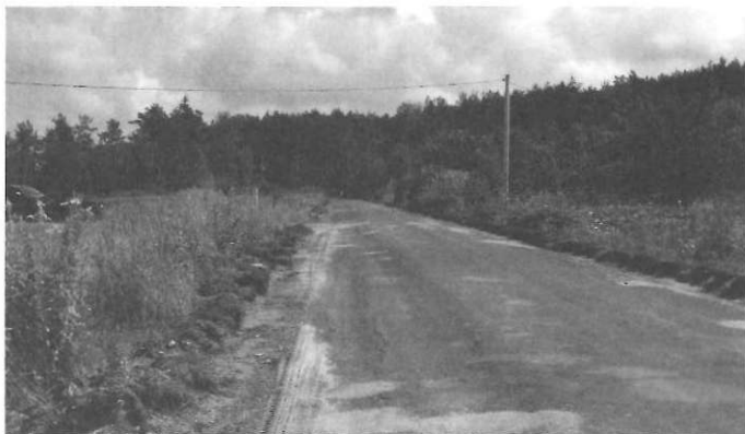
W trakcie remontu jest droga powiatowa nr 1 162 R Mielec – Rzochów – Przyłęk – Ostrowy Tuszowskie – Potrąba. Fot. A. Stec
