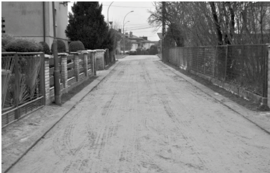
Ulica Reymonta po przebudowie
