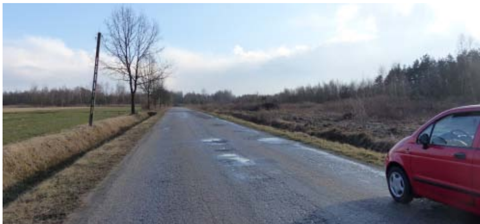
Remont dwóch odcinków drogi powiatowej ma zostać zrealizowany w tym roku. Fot. B. Żarkowska
