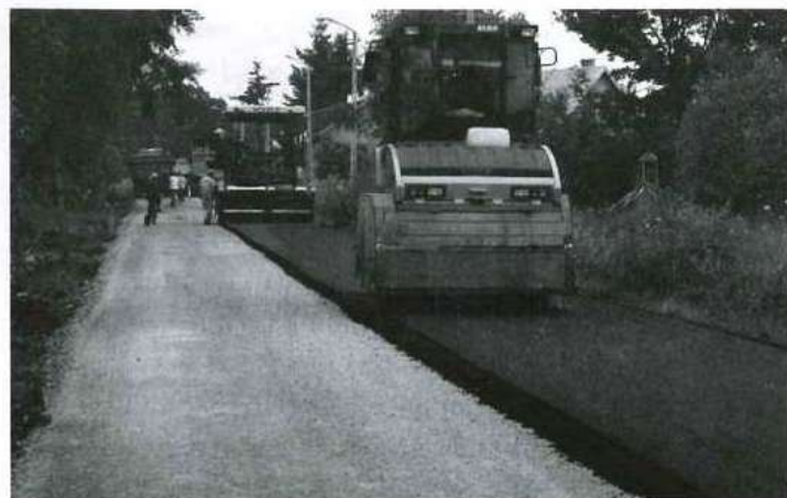
W ramach likwidacji szkód powodziowych trwa odbudowa drogi powiatowej Nr 1 227 R Trzeń-Domatków-Bukowiec-Kupno w km 3+422-4+065; 643 mb.
