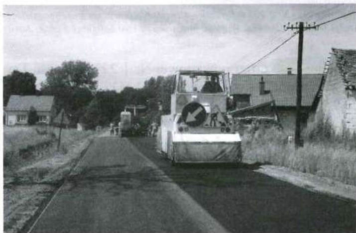
Trwa remont drogi powiatowej Nr 1 223 R Ostrowy Tuszowskie-Trzęsówka-Siedlanka, km 3+815-5+020; 1205 mb. Wartość inwestycji: 3 399 169 zł. Fot. A. Jarosz
