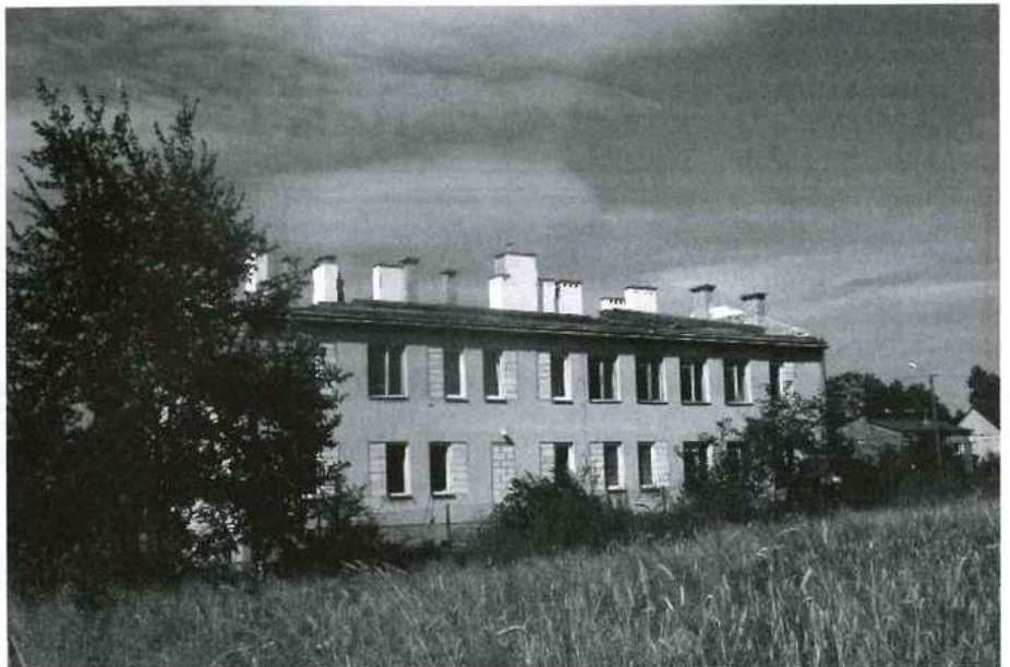
W trakcie realizacji jest budowa dachu nad budynkiem Wiejskiego Ośrodka Zdrowia w Lipnicy. Fot. S. Stec
