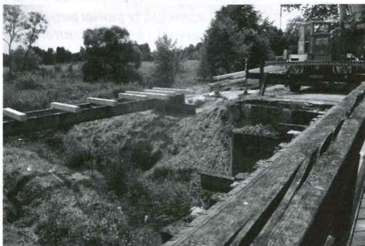
Trwają prace związane z przebudową mostu przez rzekę Turka w ciągu drogi powiatowej Nr 1 207 R Raniżów-Poręby Wolskie w km 3+778 w miejscowości Wola Raniżowska. Wartość inwestycji: 1 090 680,00 zł. Fot. A. Jarosz
