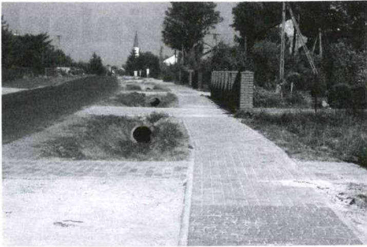
Zakończono budowę chodnika dla pieszych przy drodze powiatowej Nr 1 204 R Majdan Królewski- Kopcie-Lipnica-Raniżów-Głogów Małopolski w miejscowości Wola Raniżowska. Fot. S. Stec
