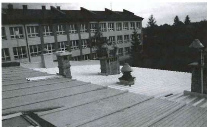
W Liceum Ogólnokształcącym w Kolbuszowej trwa remont dachu nad zapleczem sali gimnastycznej. Fot. D. Fus
