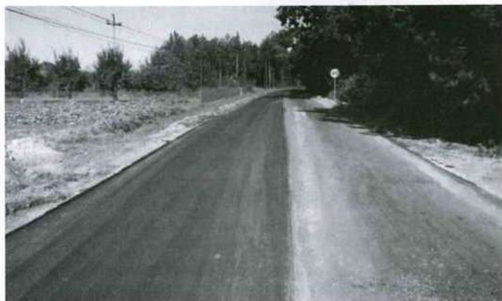
W trakcie realizacji jest modernizacja drogi 1 223 R Ostrowy Tuszowskie-Trzesówka-Siedlanka - zakres: km 0+000 - 0+944. Wartość inwestycji: 598 172,83 zł. Fot. A. Jarosz
