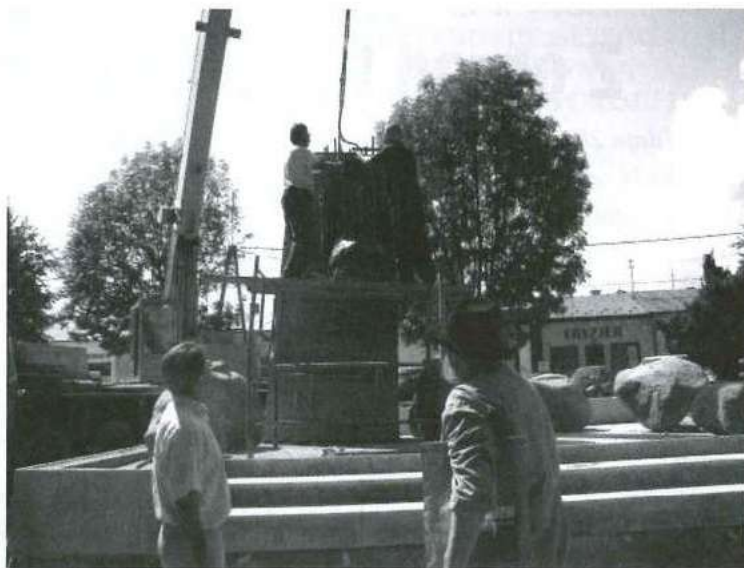
Pomnik w trakcie budowy (fot. J. Snopkowska)
