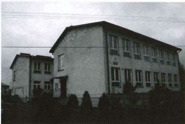
Szkoła Podstawowa w Bukowcu przed remontem
