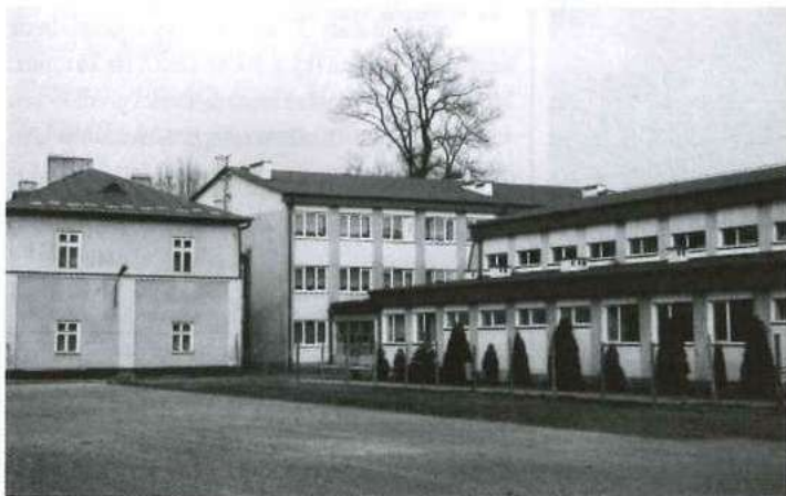
ZS Nr 1 przed modernizacją.
