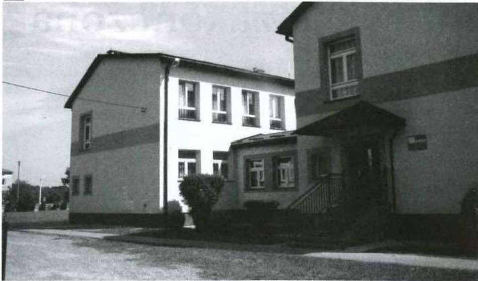
Nowy wygląd szkoły po zakończeniu termomodernizacji
