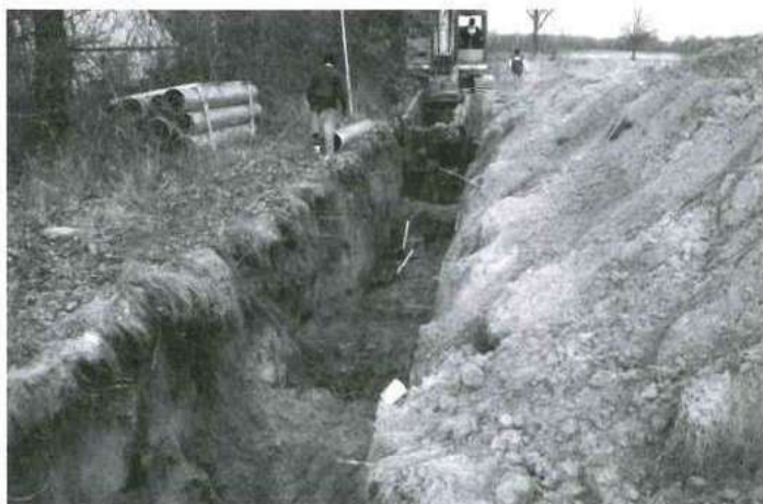
Prace przy budowie kanalizacji
