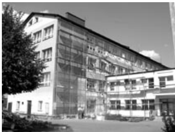
Termomodernizacja całego budynku LO łącznie z halą widowiskowo-sportową.
