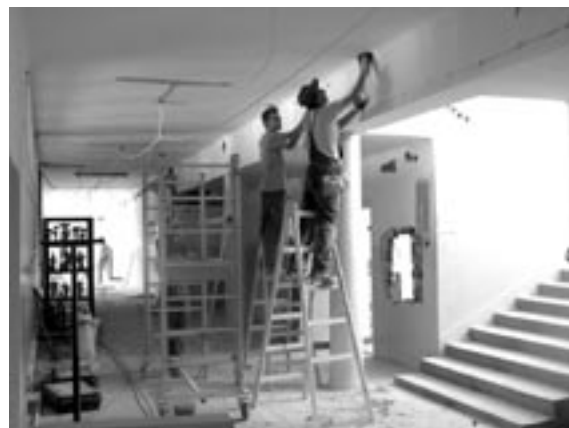
Przebudowa centralnego ogrzewania i modernizacja sieci elektrycznej w ZST.
