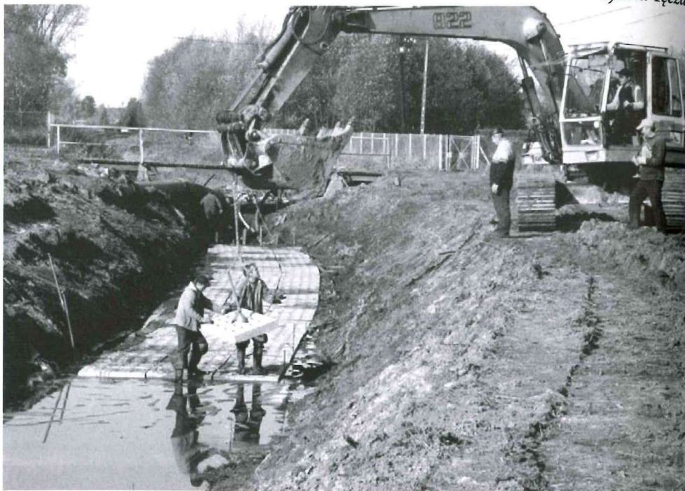
Prace na odcinku w okolicach cmentarza parafialnego w Kolbuszowej.
