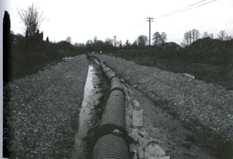
Pierwszy etap prac związanych z regulacją rzeki Nil. Inwestycja finansowana z Ministerstwa Spraw Wewnętrznych i Administracji. Fot. R. Trętowicz
