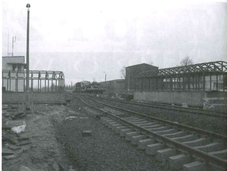
Trwają prace nad budową przejścia podziemnego. Fot. A. Jarosz
