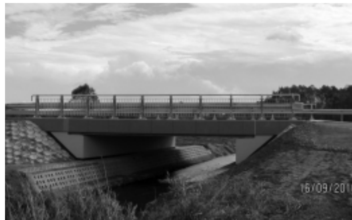
Przebudowa mostu w ciągu drogi powiatowej nr 1226 R Cmolasy - Świerców.
