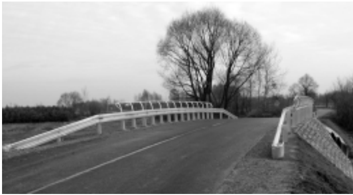
Budowa mostu przez rzekę Turka w miejscowości Wola Raniżowska w ciągu drogi powiatowej nr 1 207 R Raniżów – Poręby Wolskie. Wartość całkowita zadania to kwota 1 098 830 zł.
