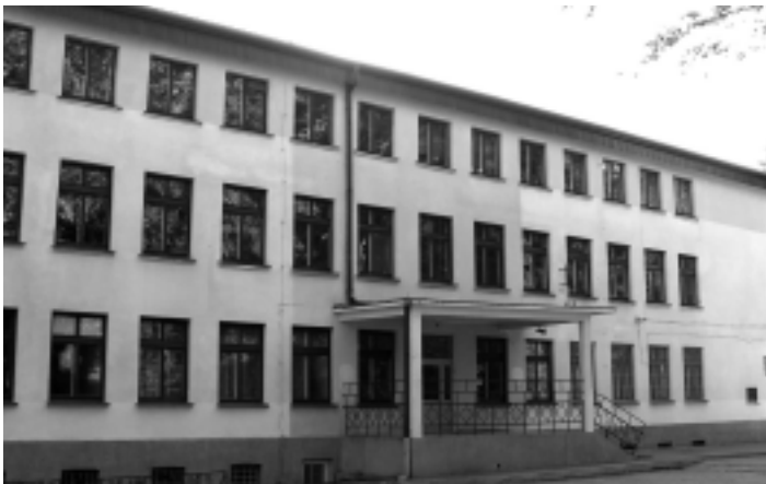
Planowana termomodernizacja Zespołu Szkół Agrotechniczno-Ekonomicznych im. Komisji Edukacji Narodowej w Weryni 2010/2011 i Przychodni Rejonowej nr 2 w Kolbuszowej. Łączny koszt inwestycji 1 424 992 zł.
