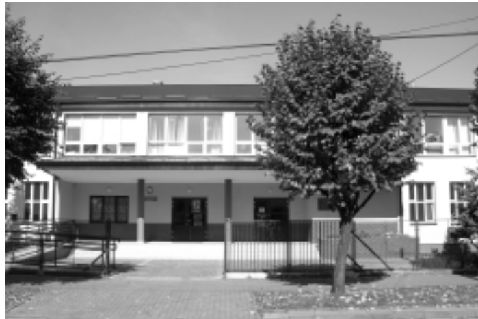
Termomodernizacja Zespołu Szkół Technicznych im. Bohaterów Września 1939 r. w Kolbuszowej.
