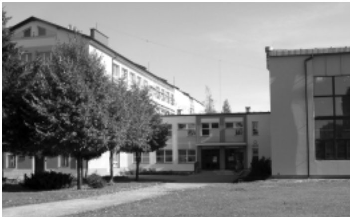
Termomodernizacja Liceum Ogólnokształcącego im. Janka Bytnara w Kolbuszowej wraz z remontem dachów na sali gimnastycznej i szatniach.
