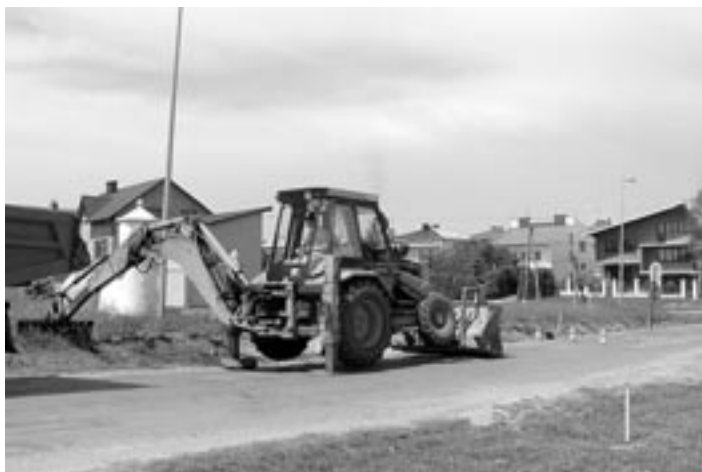
Prace remontowe przy ulicy polnej będą trwały niecałe 2 miesiące.
