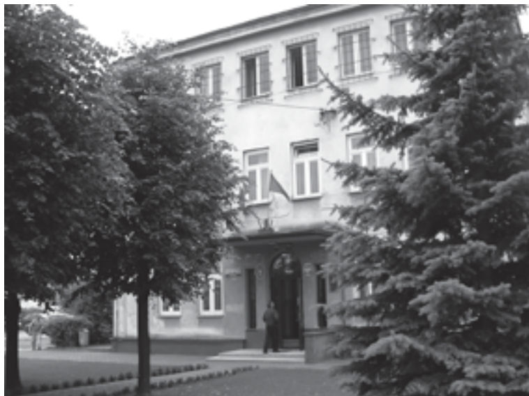
Dzięki unijnym środkom wyremontowana zostanie również elewacja budynku Urzędu Miejskiego w Kolbuszowej.
