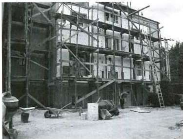
Ocieplanie ścian zewnętrznych budynku Komendy. Fot. B. Popek
