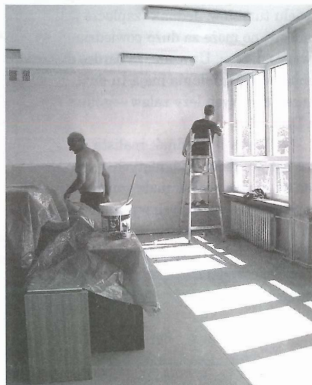
Malowanie sal lekcyjnych w budynku LO.
