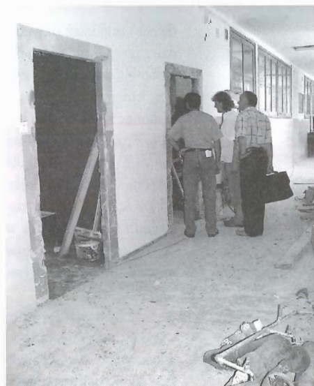
Wykonywanie nowych sanitariatów w budynku ZST.
