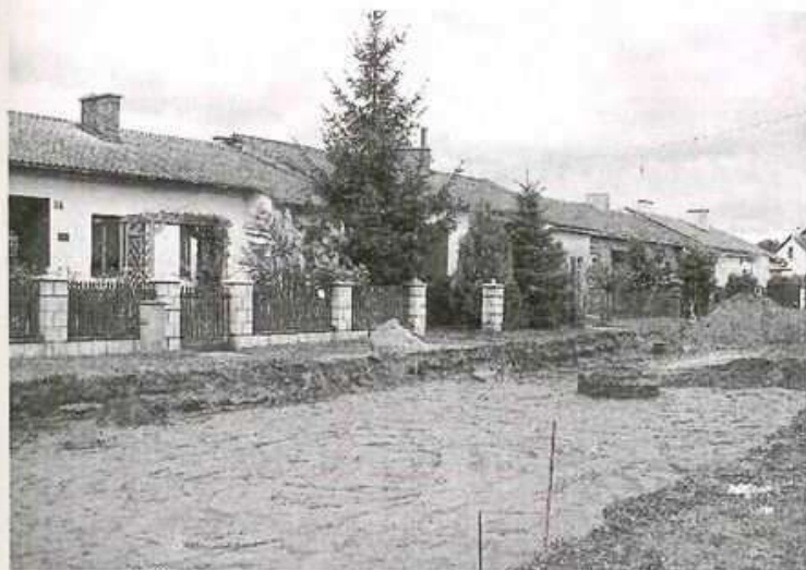
Remont ulic na Osiedlu "Prefabet".
