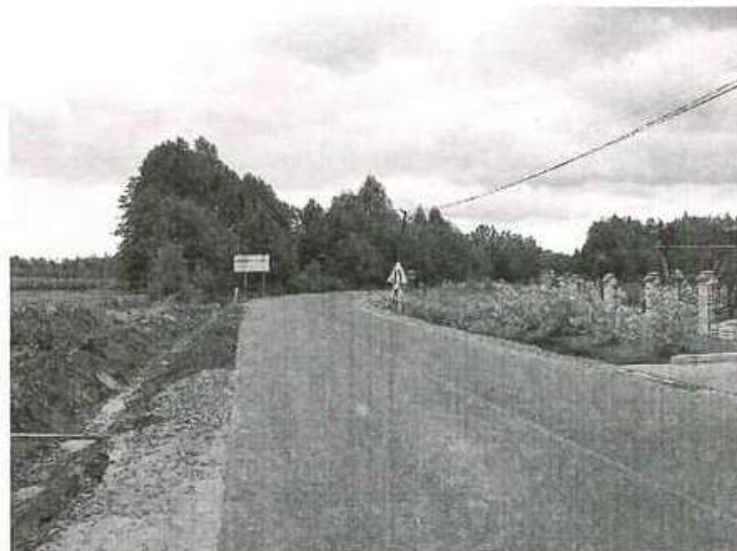
Remontowana droga wojewódzka Kolbuszowa - Sędziszów Młp.
