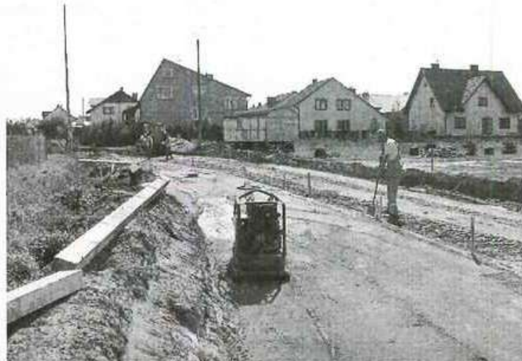
Remont ulicy Zbożowej w Kolbuszowej.
