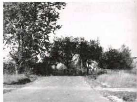
„Droga do nikąd”. Rzadko, bo rzadko, ale budowane są takie drogi.
