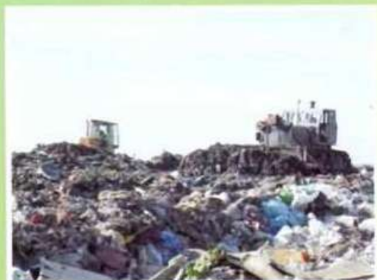
Rozpoczęcie prac- rekultywacja składowiska odpadów komunalnych w Kolbuszowej
