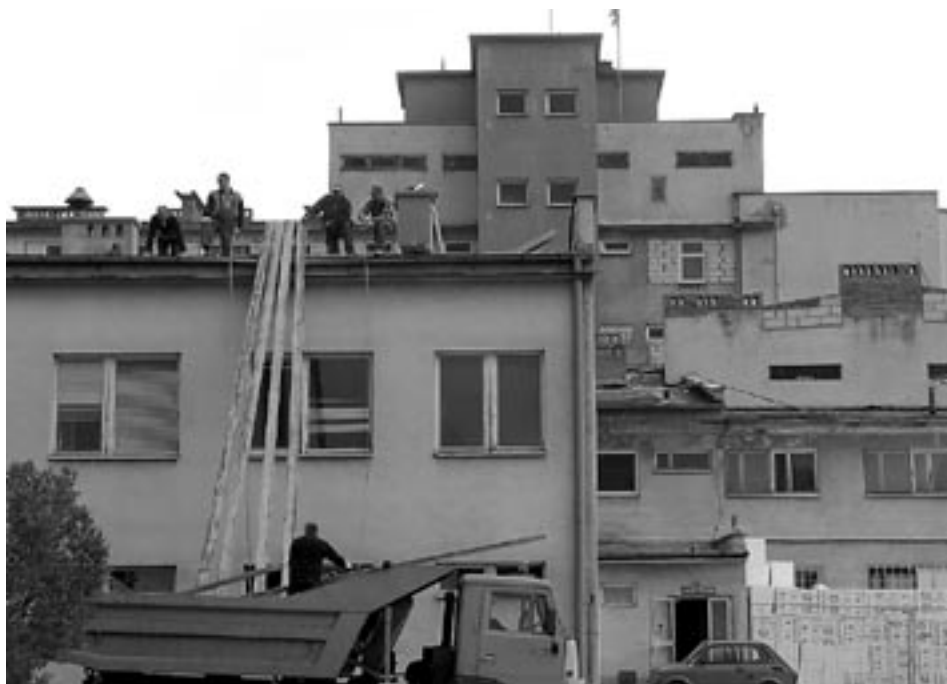
Od kwietnia firma WATEX wykonuje zmiany dachów i ocieplenie ścian kompleksu budynków Szpitala Powiatowego w Kolbuszowej. Prace mają się zakończyć w jesieni.
