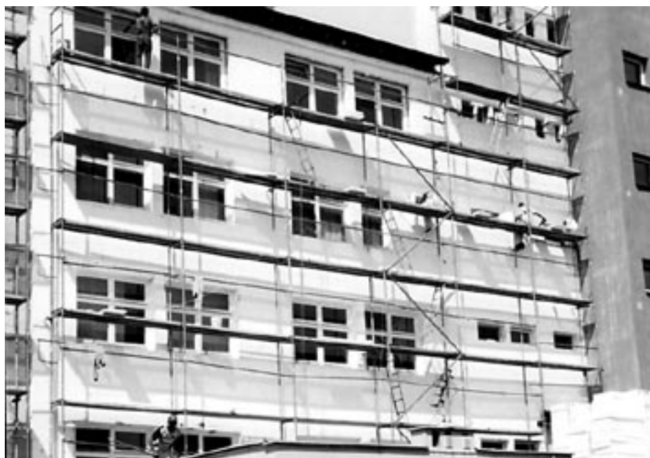
Trwa docieplanie ściany południowej szpitala.
