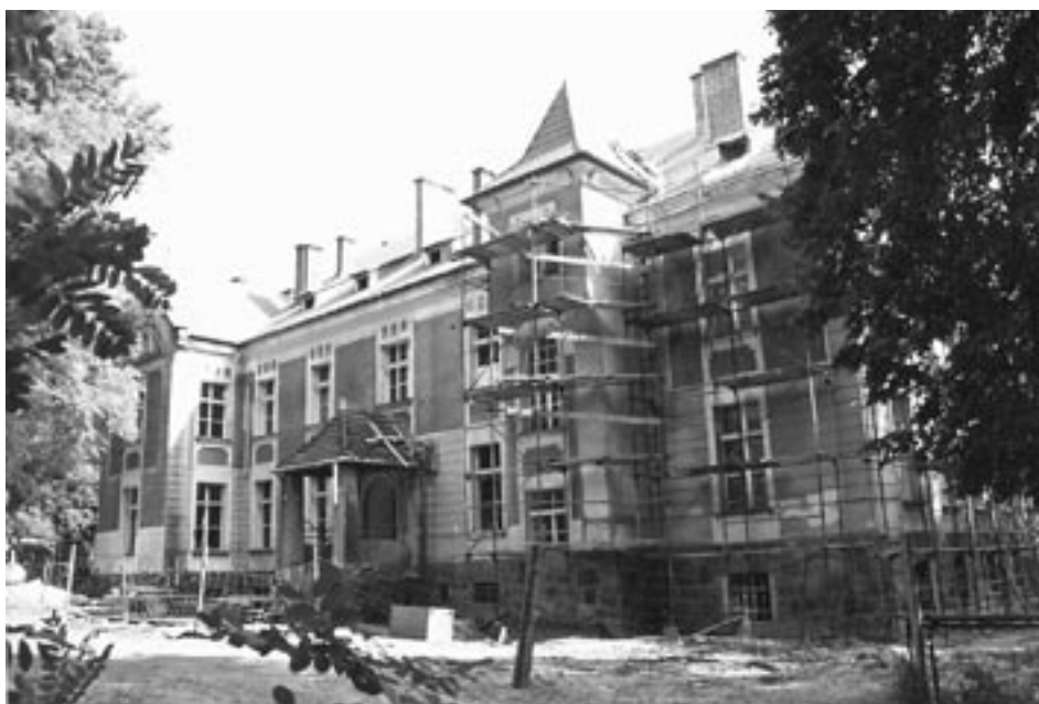
Nowy dach na pałcu i kominy już prawie skończone.
