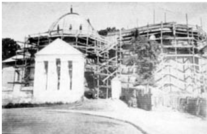
Kościół w rozbudowie (1930-33)
