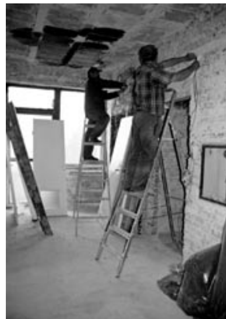
Trwają intensywne prace remontowe. Robotnicy pracują od 7-mej do 17-tej.
