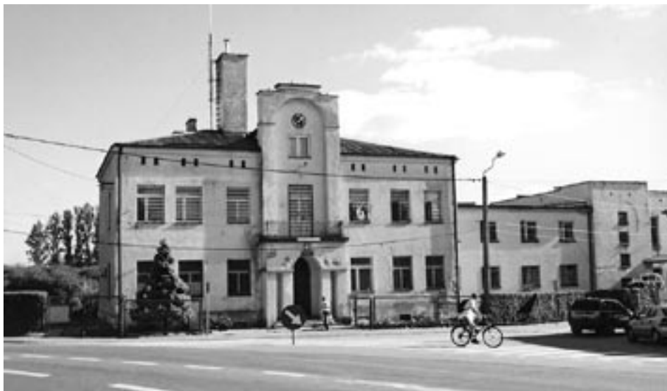
Już wkrótce z budynku Komendy Policji znikną niepotrzebne kraty i komin.
