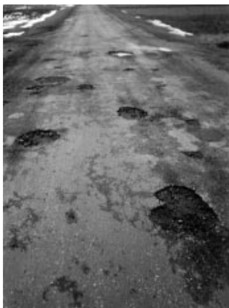
Ta zima była wyjątkowo długa, mroźna i niekorzystna dla dróg. Mróz zniszczył starą nawierzchnię bitumiczną.
