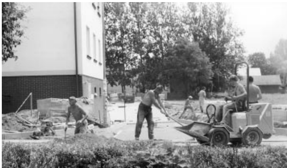
Ostatnie prace przy wjeździe na parking Starostwa.
