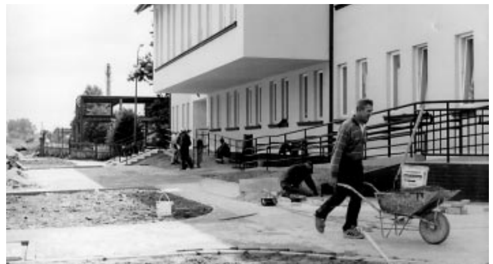
Ostatnie prace wykończeniowe przed budynkiem Starostwa - układanie kostki brukowej. Fot. B. Popek
