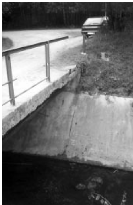
Ukradziona część barierki mostu.
