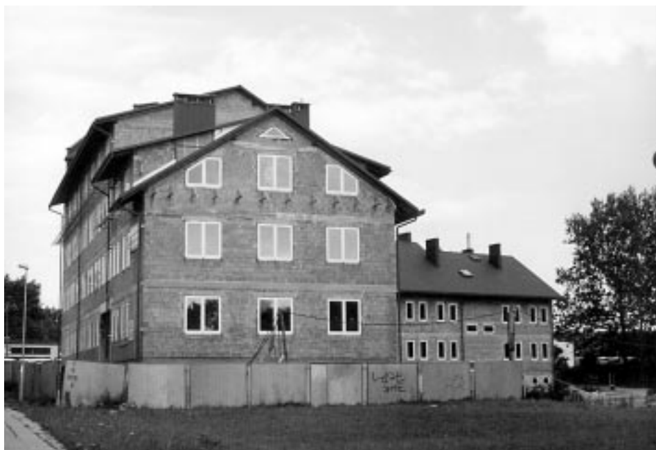
Trwają prace wykończeniowe w budynku administracyjnym Starostwa Powiatowego.
