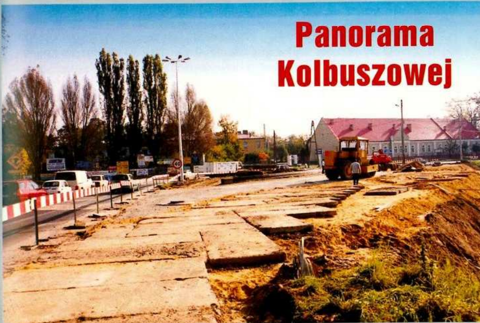
Nowe rondo w budowie...
