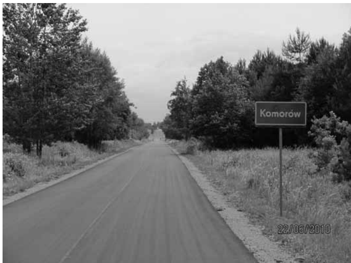
Nowa nawierzchnia w Komorowie.
