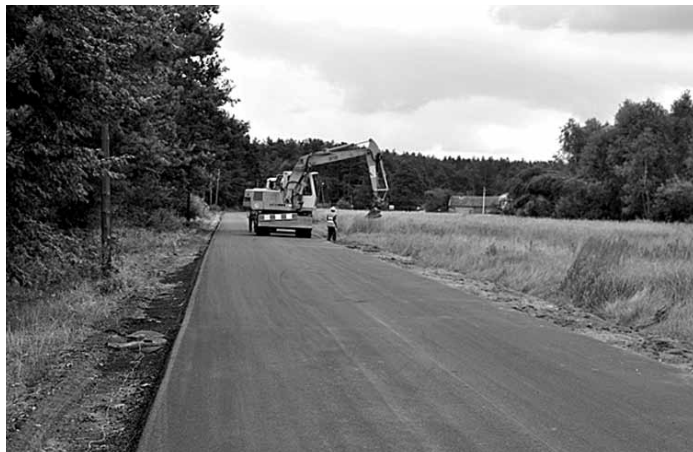
Zakończono remont drogi powiatowej nr 1 223 R Ostrowy Tuszowskie – Trzęsówka – Siedlanka. Długość zmodernizowanego odcinka to 1120 mb. Fot. A. Jarosz
