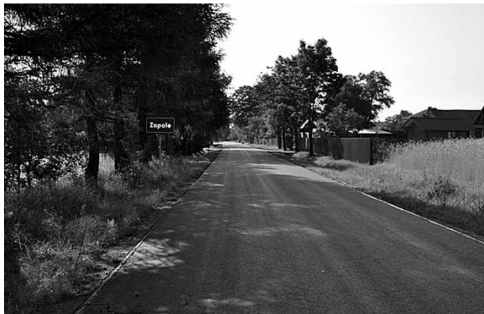
Zakończono remont drogi powiatowej nr 1 227 R Trześć – Zapole – Domatków na długości odcinka 2128 mb. A. Jarosz
