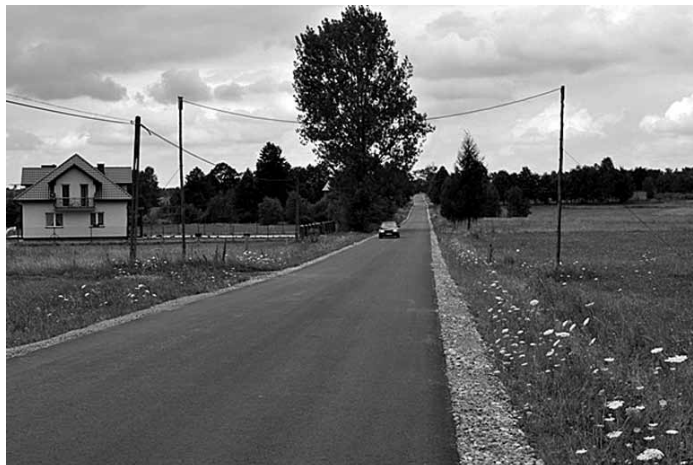
Zakończono remont drogi powiatowej nr 1 225 R Kosowy – Niwiska na długości odcinka 1605 mb. A. Jarosz
