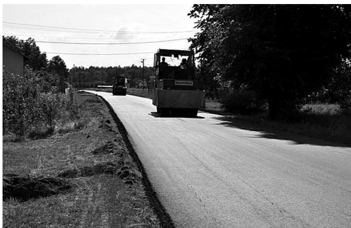
W trakcie remontu jest droga powiatowa nr 1 206 R Wola Raniżowska przez wieś. Długość zmodernizowanego odcinka 603 mb. Fot. A. Jarosz
