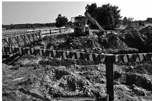
Trwa przebudowa mostu w ciągu drogi powiatowej nr 1 226 R Cmolas - Świerczów. Fot. A. Jarosz
