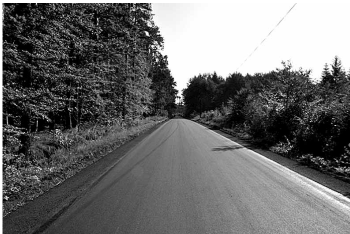
Zakończono remont drogi powiatowej nr 1 230 R Nowa Wieś – Zapole – Hucisko w gminie Kolbuszowa. Długość zmodernizowanego odcinka 330 mb. Fot. A. Jarosz
