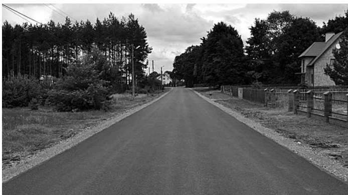
Zakończono remont drogi powiatowej nr 1 162 R Rzochów – Przyłek na długości odcinka 1150 mb. A. Jarosz
