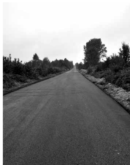
Zakończono remont drogi powiatowej nr 1 226 R Cmolas – Świerczów. Fot. A. Jarosz
