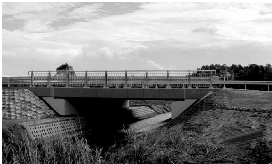
Stary most został całkowicie rozebrany, a w jego miejsce wykonano nowy. Fot. Archiwum
