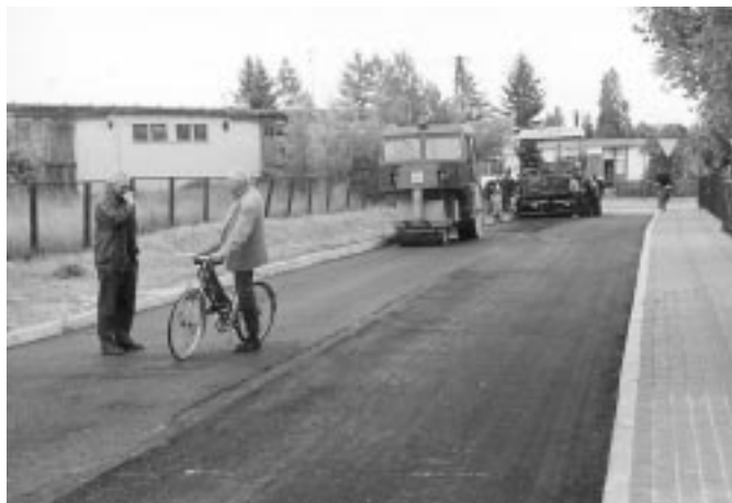
W ostatnich dniach maja br. Raniżów wzbogacił się o nowy odcinek drogi asfaltowej do stadionu sportowego. Jako pierwsi testowali nową nawierzchnię radny Marian Pomykała i sołtys Edward Warzocha.
