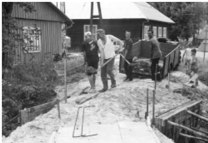
Prace przy betonowaniu przepustu w centrum wsi.
