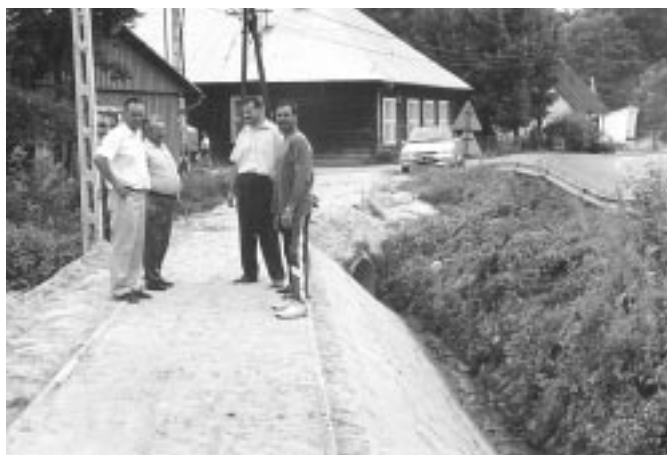
Przedstawiciele Urzędu Gminy kontrolują przebieg robót.
