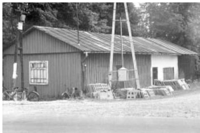
Barak - remiza Ochotniczej Straży Pożarnej w Staniszewskim.
