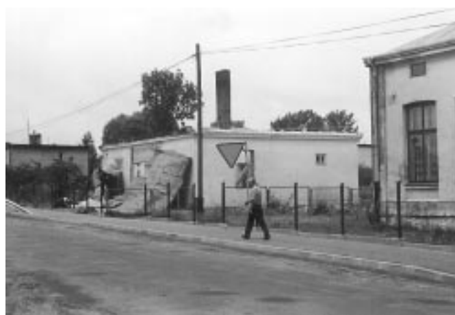
Budynek - mieszkanie dyrektora Szkoły Podstawowej w Woli Raniżowskiej (już w trakcie rozbioru).
