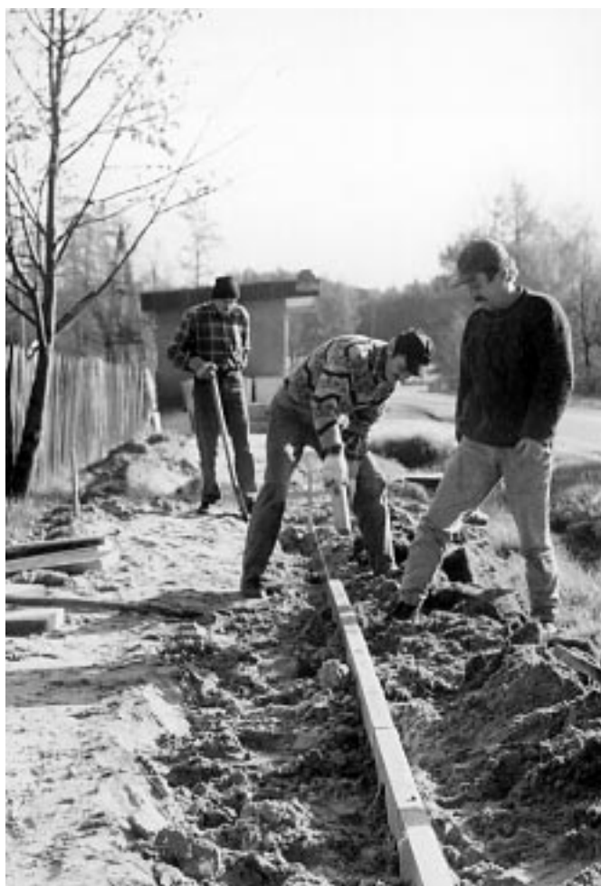
Ostatnie płytki przy budowie chodnika w Zielonce kładzione były obok przystanku PKS.
