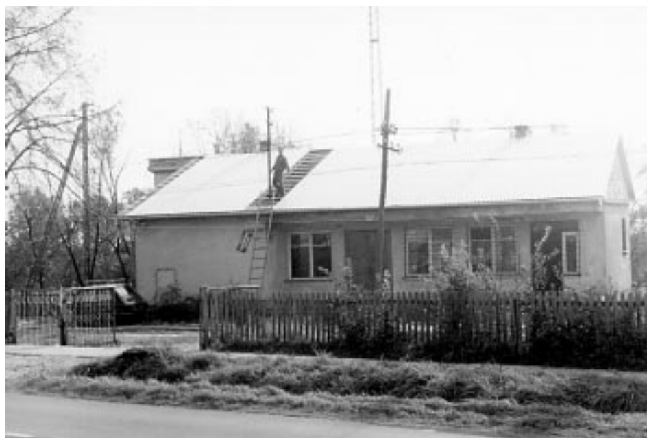
Dom Ludowy w Zielonce zyskał nowe pokrycie dachowe.
