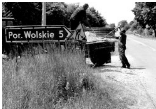
Pracownicy Urzędu Gminy Stanisław Ofiara i Wojciech Kopeć remontują nawierzchnię drogi do Lisów.
