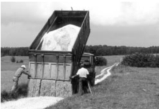
Utwardzanie kamieniem drogi gminnej w Korczowiskach.
