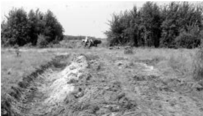
W lipcu wybudowano nowy odcinek drogi, na razie o nawierzchni piaszczystej, częściowo utwardzony kamieniem, wzdłuż zalewu Maziarnia.
