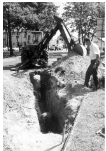
Dobudowa odcinka kanalizacji burzowej w centrum Raniżowa obok przystanku PKS.
