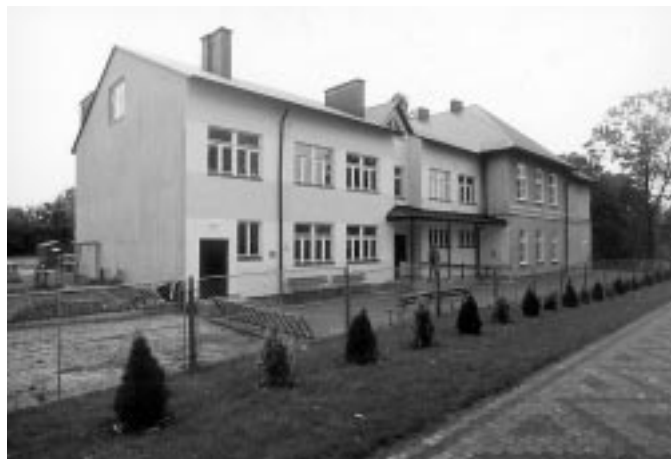
Budynek Szkoły Podstawowej w Mazurach. Na pierwszym planie oddana do użytku w dniu 5.01.2002 r. nowa część dydaktyczna z zapleczem socjalnym.
