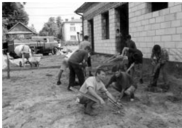
W tym miejscu przed Domem Ludowym powstanie podłoga taneczna. Na zdjęciu: prace przy wykopach pod betonowe podstawy.
