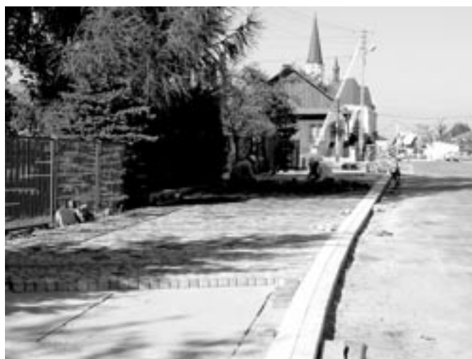
Układanie parkingu przed budynkiem Szkoły Podstawowej.
