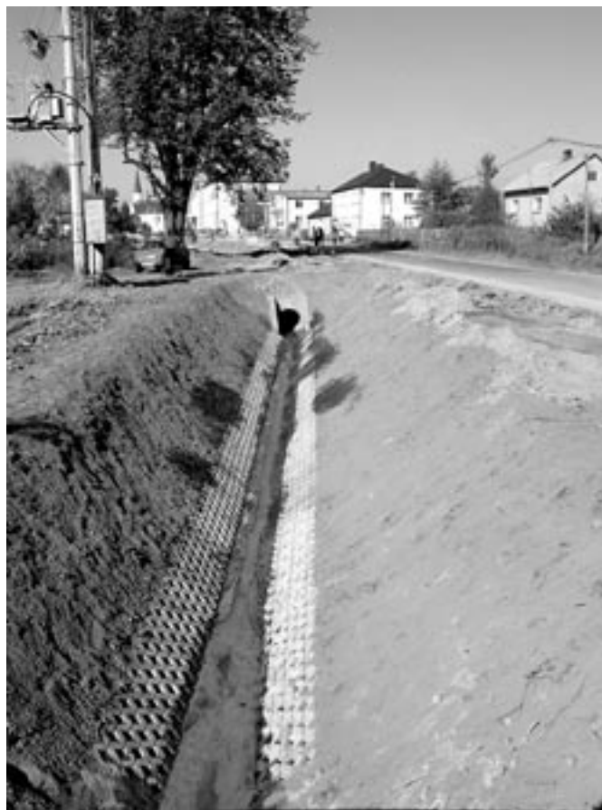
Nowy „przełożony” rów melioracyjny. Pomiędzy nim a koroną drogi zostanie ułożony chodnik z kostki.
