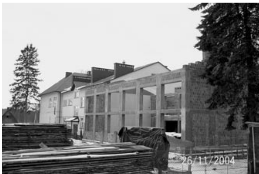
Budowa sali gimnastycznej przy Szkole w Mazurach.
