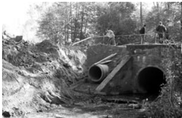
Powiększanie przepustu na Os. Wilki w Raniżowie.
