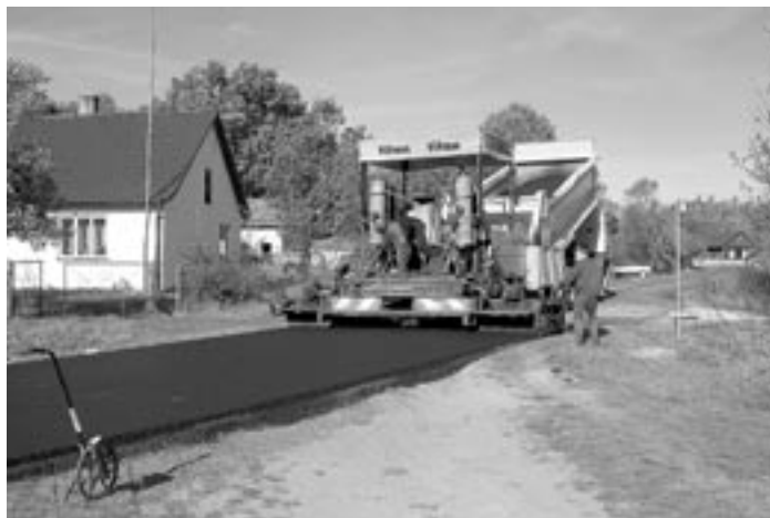
Asfaltowanie ul. Ks. Sudota w Raniżowie.
